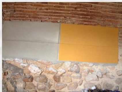
3. APLICACIÓN DE REVOCO Mortero de cal hidrofugado en masa
