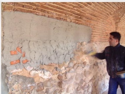
2. APLICACIÓN DE ENFOSCADO Mortero de cal/cemento hidrofugado en masa
